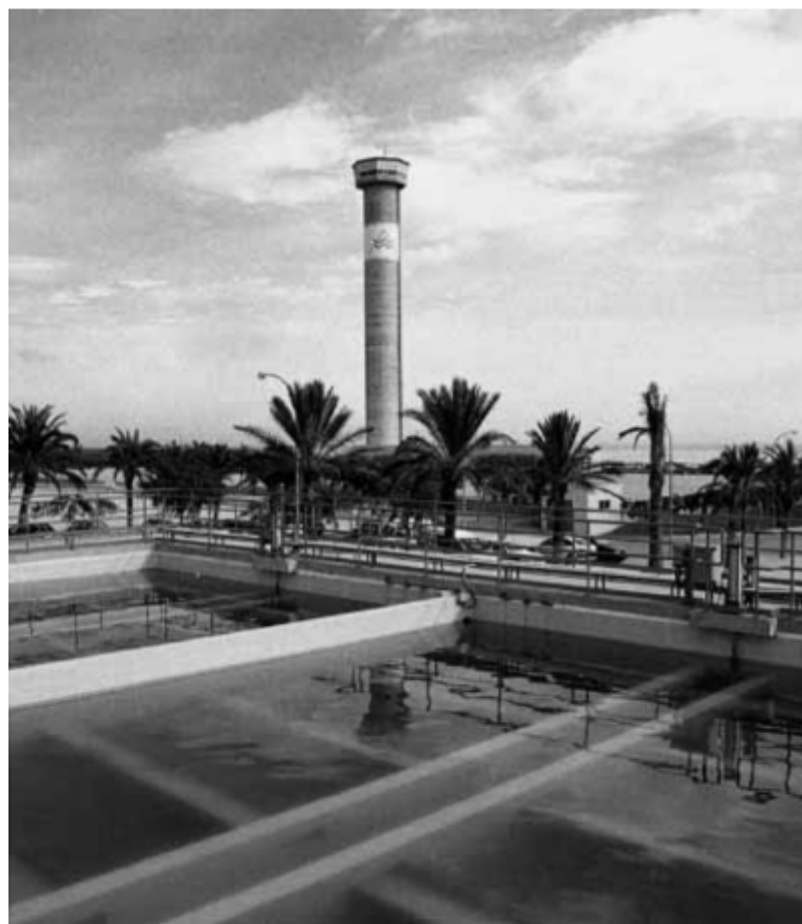
Planta potabilizadora de l'Ampolla
